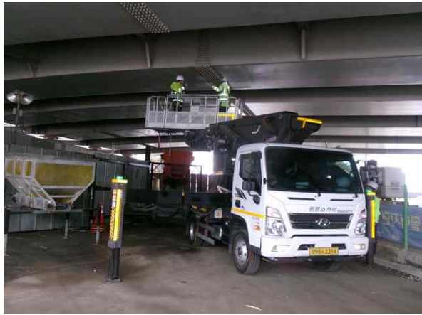
고소차를 이용한 근접조사
