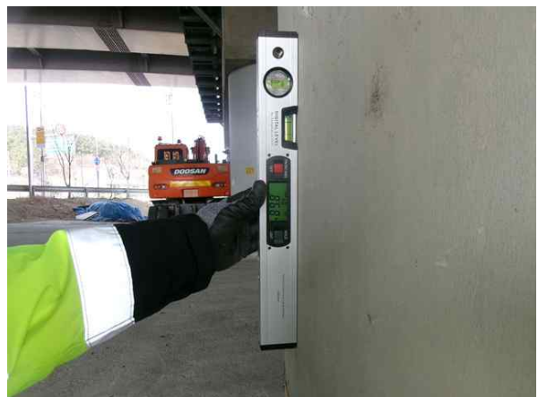
교각 변위측정 작업사진
