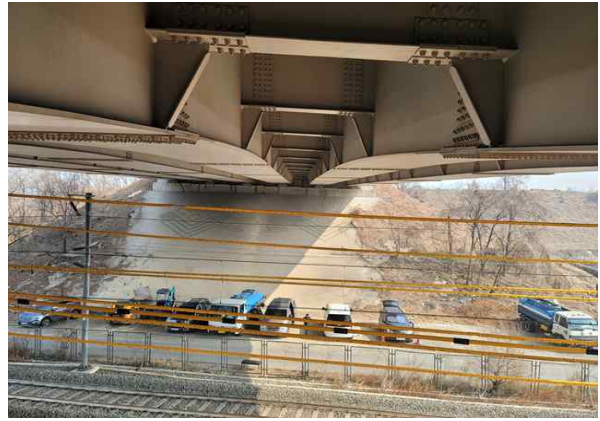
교대 A2 기초 전경
