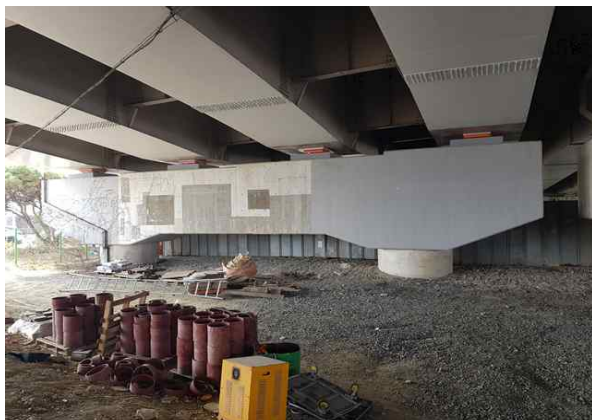
교각 P1 기초 전경
