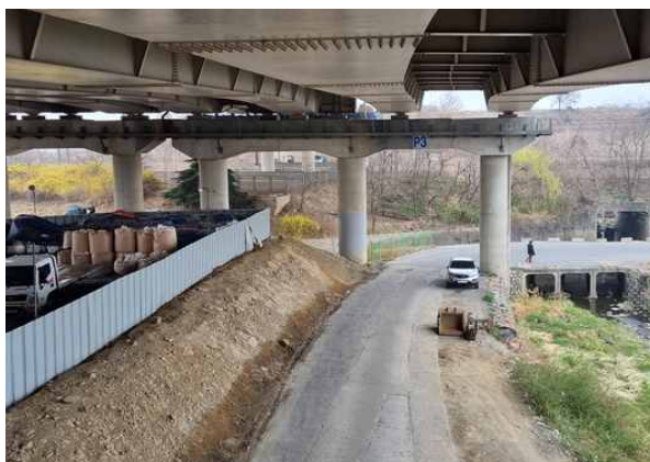
교각 P3 기초 전경
