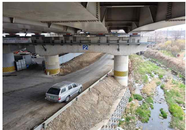
교각 P2 기초 전경
