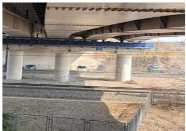
교각 P4 기초 전경
