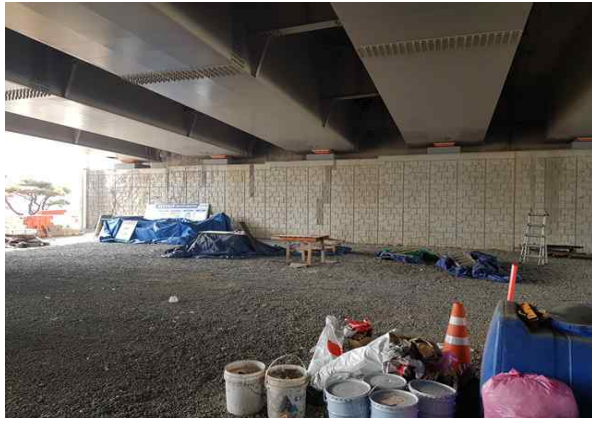
교대 A1 기초 전경
