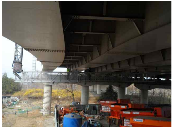
굴절작업차를 이용한 근접조사
